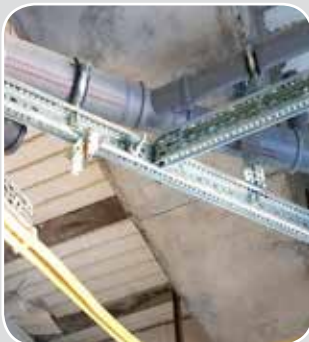
■ خلاقیت مجری در استفاده از سوپرفیکس و متعلقات جهت مهار لوله‌های فاضلاب
