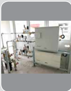
■ نصب تجهیزات مینی چیلر با استفاده از سوپرفیکس به زیباترین شکل در کم‌ترین فضای ممکن
