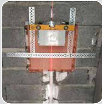
■ نصب فلاش تانک توکار با استفاده از سوپرفیکس تخت
