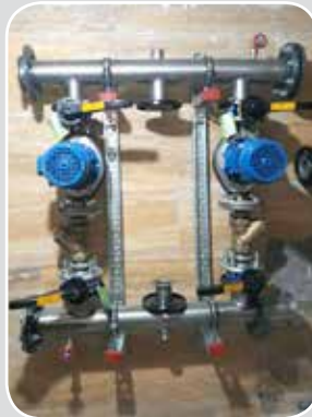
■ انعطاف سوپرفیکس امکان رگلاژ کلکتورها پس از نصب را نیز فراهم می‌کند.
