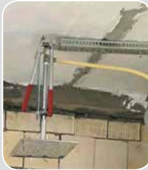
■ نصب لوله‌کشی دوش توکار با تلفیق سوپرفیکس تخت و U با امکان رگلاژ
