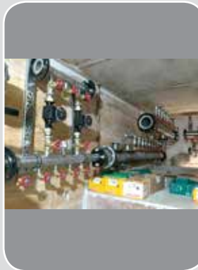
■ خلاقیت مجری در مهار کلکتورهای مختلف با استفاده از قابلیت‌های سوپرفیکس
