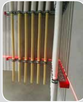
■ سلیقه مجری در استفاده از پروفیل U و بست‌های روکش‌دار سوپرفیکس
