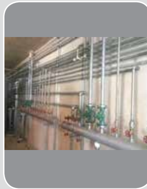
■ اجرای ساپورت لوله و کلکتورهای فلزی بر روی دیوار و کف با استفاده از سوپرفیکس U
