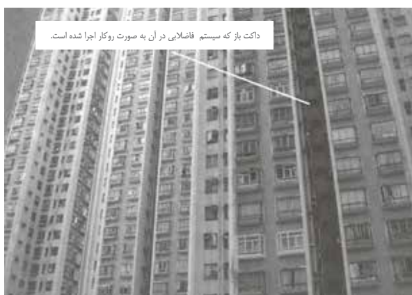
شکل ۲- داکت بین سرویس‌های حمام و توالت که به صورت باز اجرا شده است.
