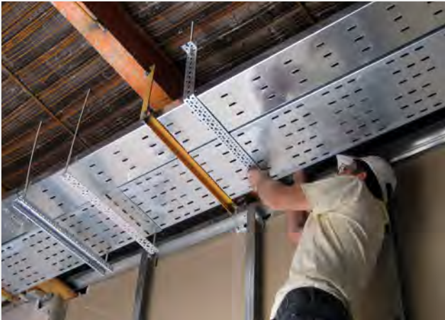
مقایسه‌ی اجرای سوپرفیکس برای مهار سینی برق با اجرای نبشی مجری: گروه پارت‌آریا
