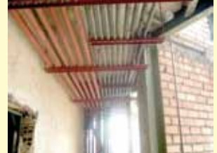
اجرای درست عایق درست
