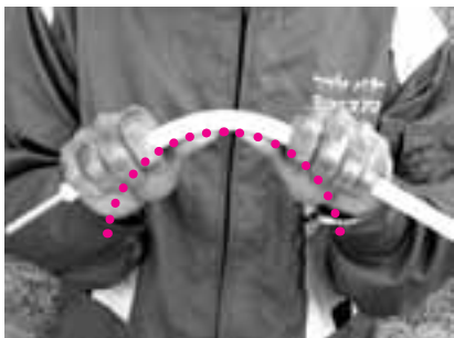
خم کردن لوله با استفاده از فنر
