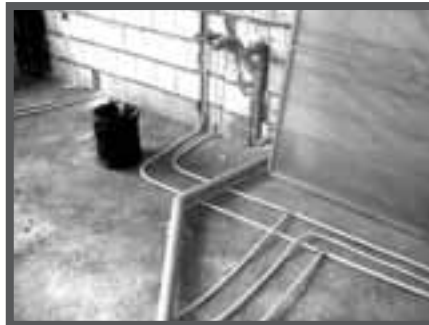
✓ با استفاده از سهراهی، دو سرویس را به صورت مجزا اجرا کرده است
