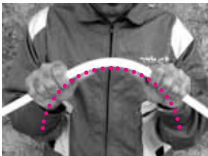
خم کردن لوله با دست بدون استفاده از فنر
