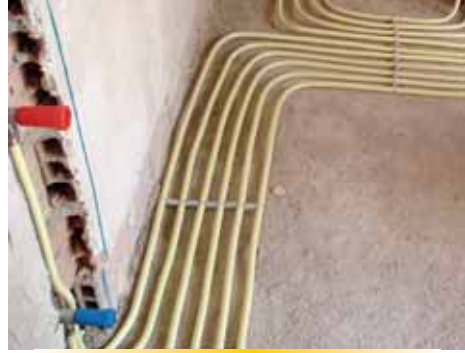
فاصله مجاز بین لوله های سرد و گرم رعایت شده است
