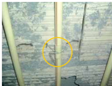
در بستن لوله با سیم ملاحظات لازم در نظر گرفته شده است.
