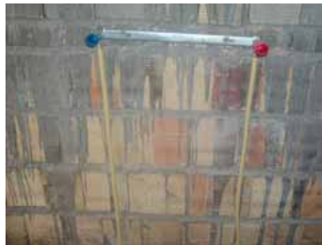
لوله بصورت عمودی روی دیوار اجرا گردیده است و صفحه به دیوار پیچ و رولپلاک شده است
