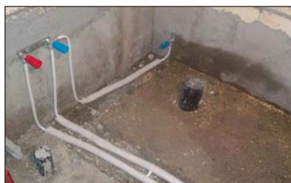
محکم کردن صفحه دیواری بر روی سیمان، به وسیله پیچ و رولپلاک
