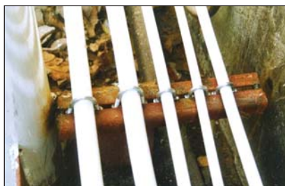
اجرای ساپورت به وسیله بست کبری
