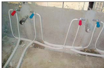
اجرای افقی لوله ها باید روی کف انجام شود.
