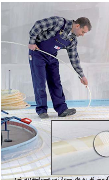
روش جدید نصب گرمایش کفی: به جای بست از زیپ چسب استفاده می‌شود
