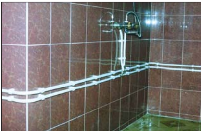
اجرای بست روکار
