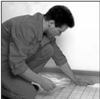
همچنین سیستم گرمایش کفی برای کفهای مختلف با پوشش‌های متفاوت از جمله پارکت‌های چوبی و موکت مناسب می‌باشد ولی سنگ و سرامیک به ترتیب بهترین نوع کف برای گرمایش کفی است.
