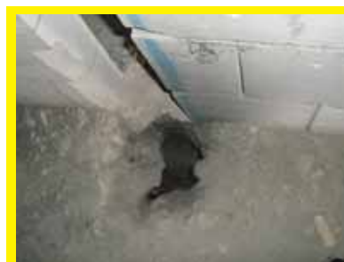
استفاده نادرست از ابزار کرگیر، و بریدن میلگرد با هوابرش باعث ایجاد جرعه و آتش و انتقال آن به انبار شده است.
